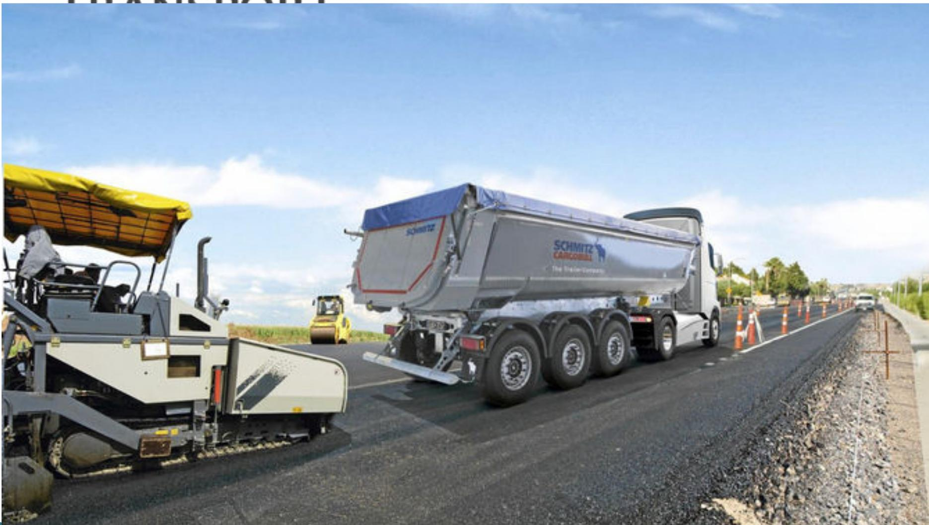
da omogućuje ~~ugradnju~~ ugradnju bitumenskin mjesavina bez zastoja
